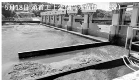
図5 5月18日頭首工上流側(水位低下状況)
