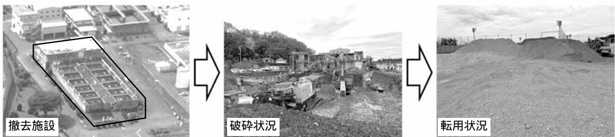
図-3 水処理施設撤去状況
