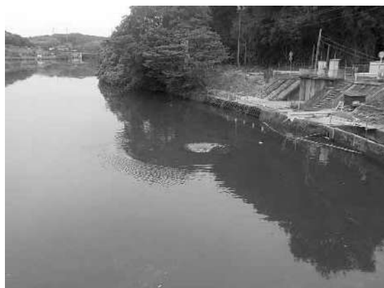
図2 漏水写真(a)上流吸込部
