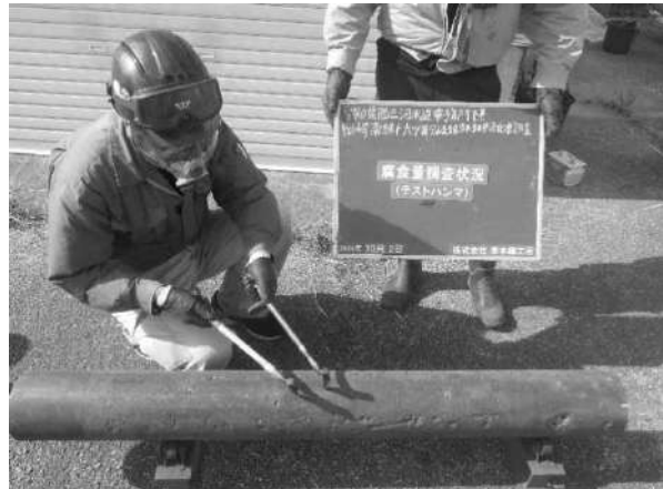
図3 管外面腐食量調査の様子
