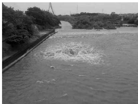
図3 漏水写真(b)下流噴出部
