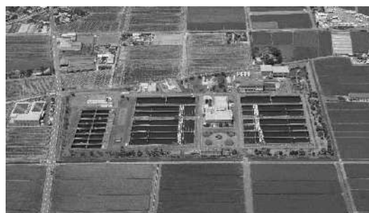
図4 安城浄水場写真
