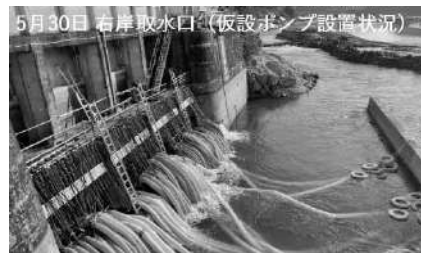
図6 5月30日右岸取水口(仮設ポンプ設置状況)
