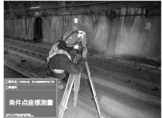
図 - 9 トンネル内測量状況
