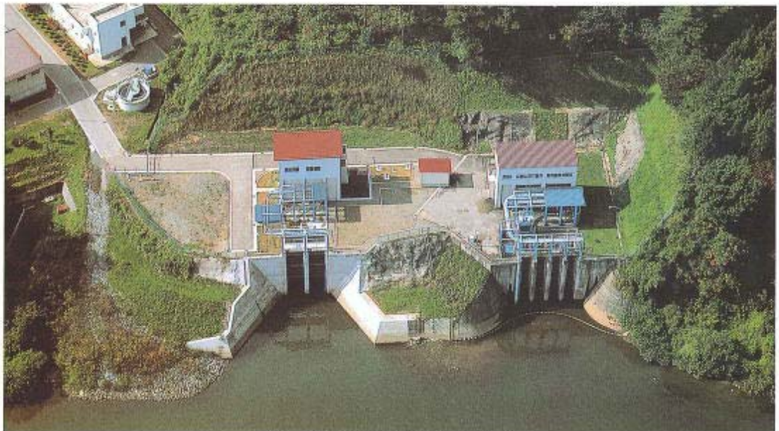
(第一北上中部工業用水道 取水口)
