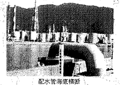
配水管海底横断
